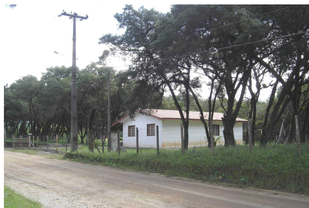
Foto 3 – Casa construída sobre o aterro de dolina, em Colombo. Foto: 2007.
