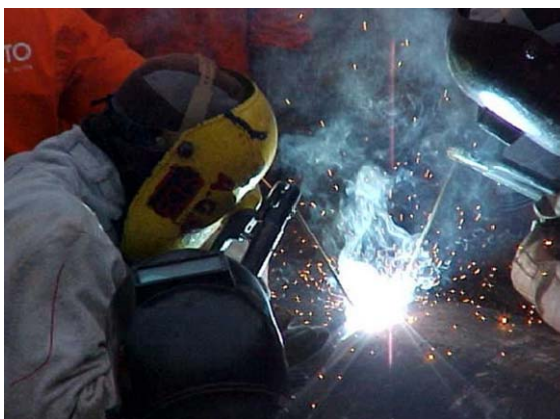
Figura 9-58 - Soldagem dos tubos do duto.
