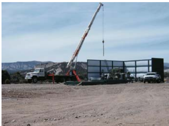
Figura 9-60 - Exemplo de operação de equipamentos com a utilização de barreiras sonoras.
