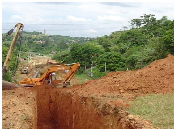
Figura 9-57 - Abertura de vala para o duto.
