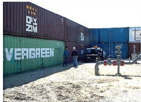
Figura 9-60 - Exemplo de operação de equipamentos com a utilização de barreiras sonoras.
